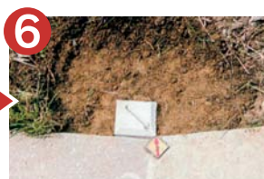
埋め戻して設置完了。
