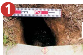
境界標を埋める為の穴を掘る。
