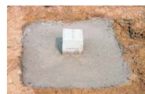
コテで仕上げて完成。
