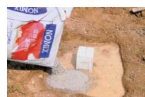
上面舗装の大きさ・厚み分だけ土を掘り、水を入れ、NOMIXを入れる。
