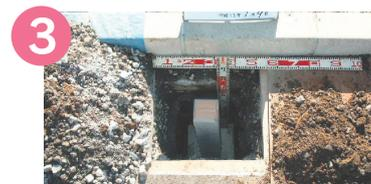
3 底盤石・コンクリート杭を設置する。
