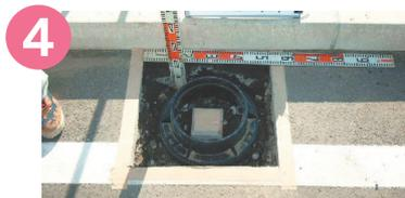
4 埋め戻し、ポイントホールの台座部分を設置する。
