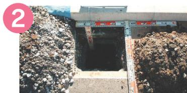
2 底盤石・コンクリート杭を埋める為の穴を掘る。
